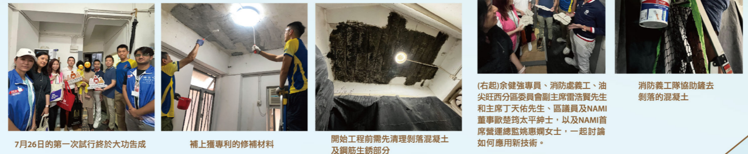
7月26日的第一次試行終於大功告成 補上獲專利的修補材料 開始工程前需先清理剝落混凝土及鋼筋生銹部分
