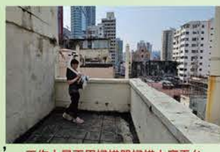
工作人員正用掃描器掃描大廈天台
